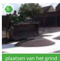
6 plaatsen van het grind
