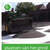
plaatsen van het grind
