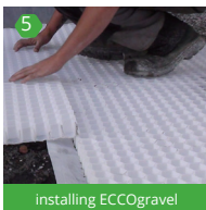
installing ECCOgravel
