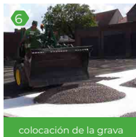
colocación de la grava
