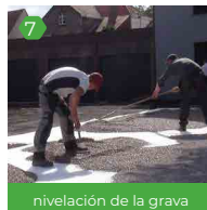
nivelación de la grava
