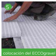
colocación del ECCOgravel
