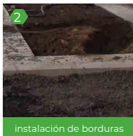
instalación de borduras
